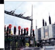
Im Umspannwerk wird die Spannung des Stroms verringert.
